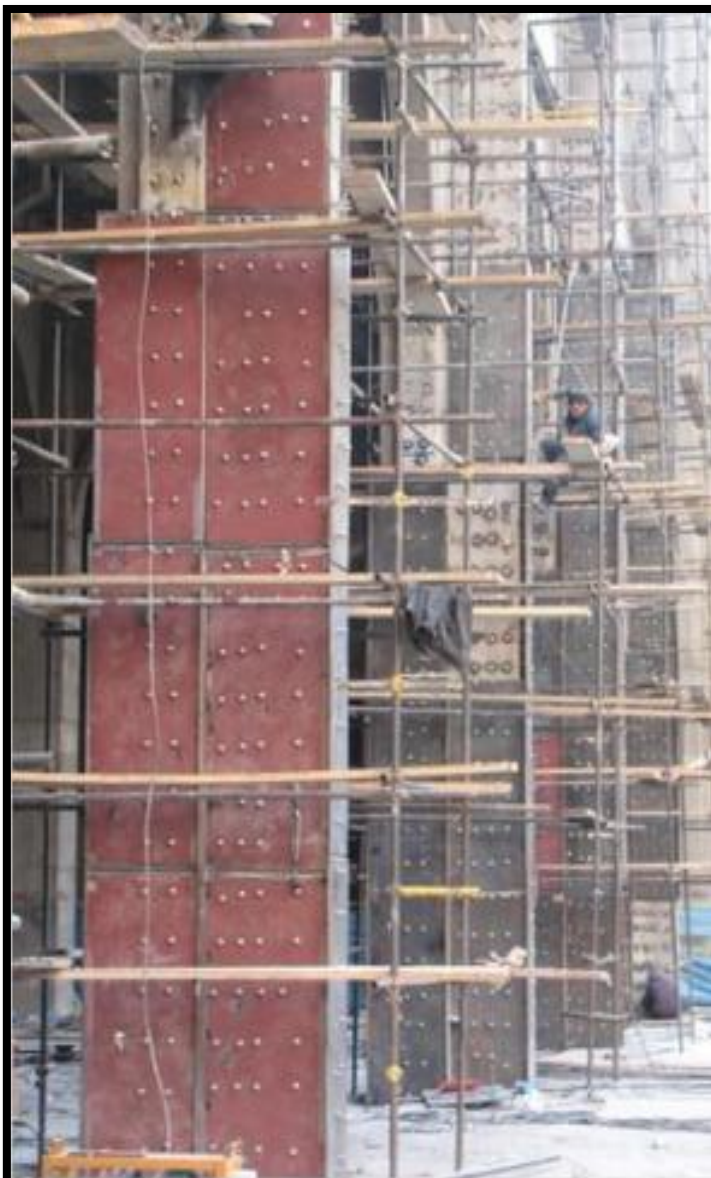
مقاوم سازی ستونهای بتنی با روش Steel Jacketing - مصلی بزرگ تهران
