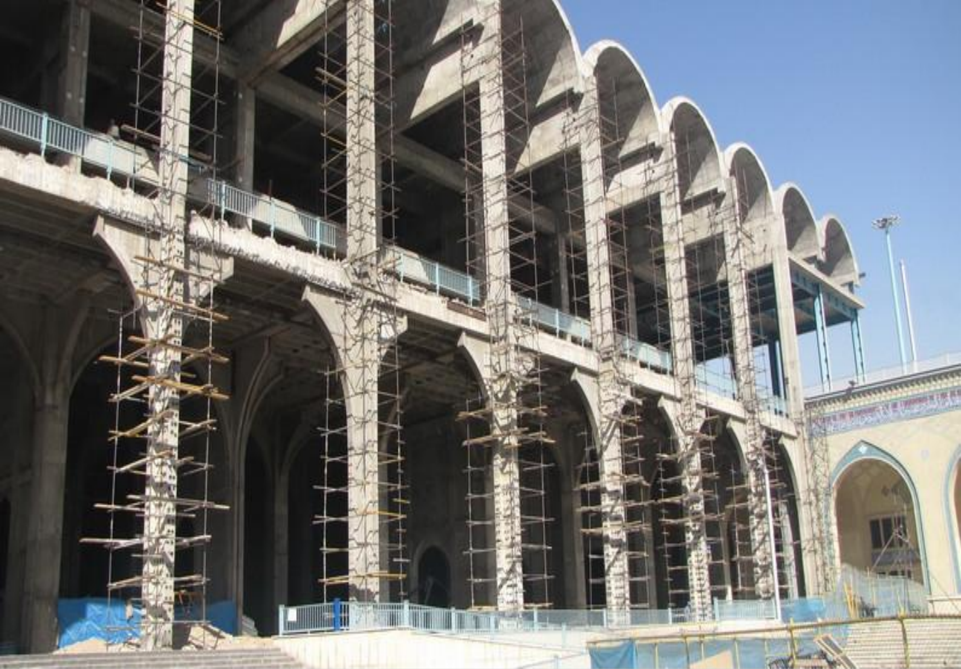
مقاوم سازی ستونهای بتنی با روش Steel Jacketing - مصلی بزرگ تهران
