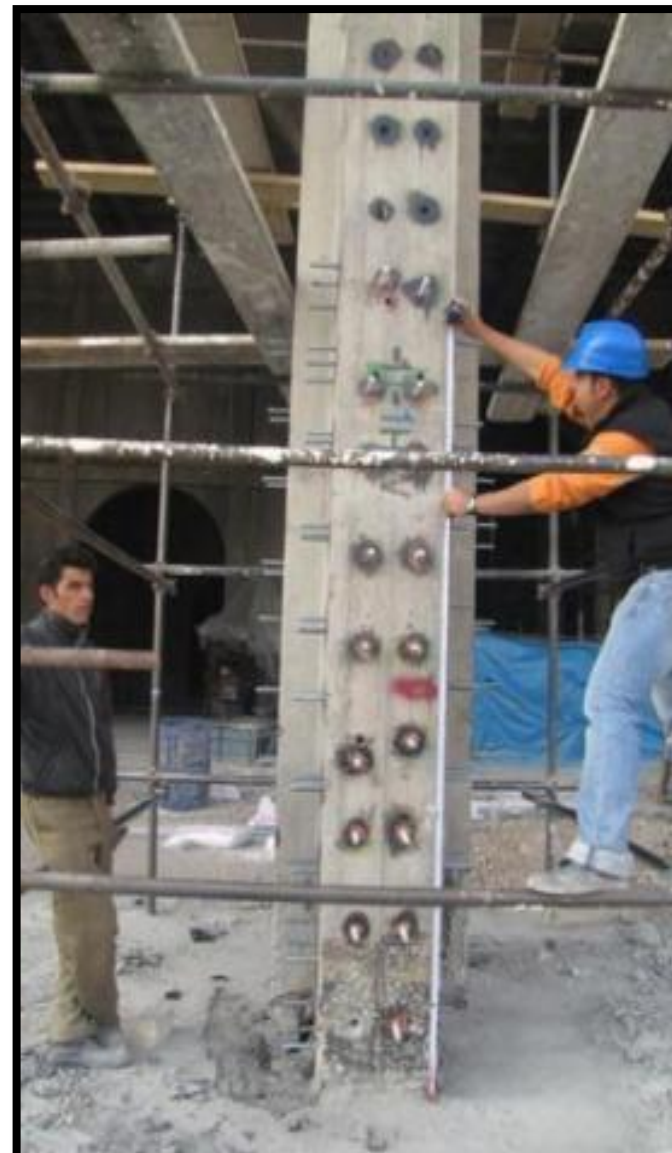
مقاوم سازی ستونهای بتنی با روش Steel Jacketing - مصلی بزرگ تهران
