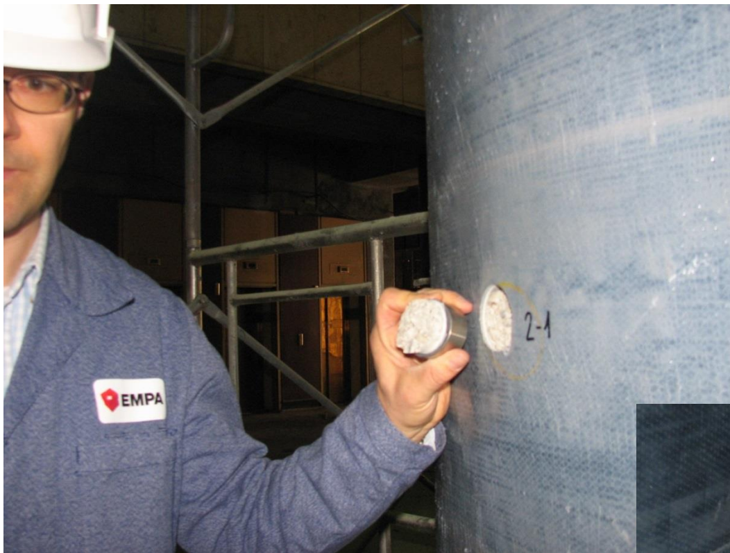
تست اجرا (Pull off test)
