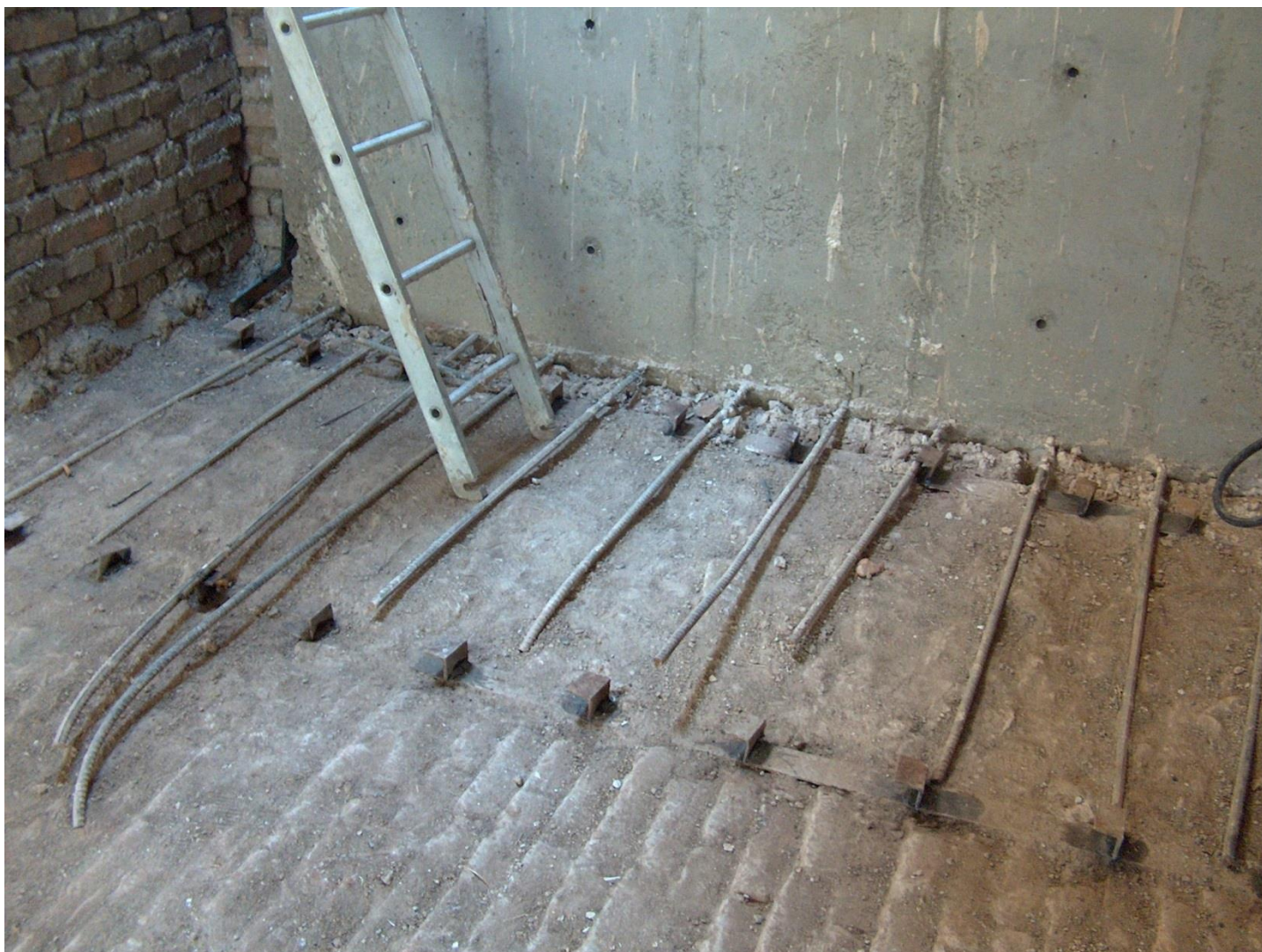
دیوار برشی جدید و اجرای سقف کامپوزیت
